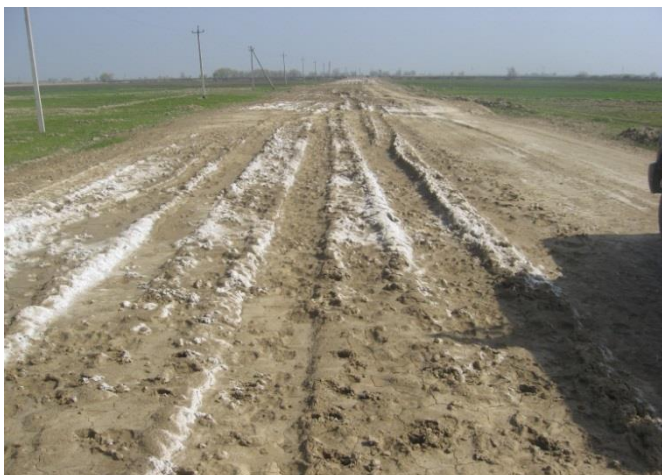
4.9-rasm. Yo‘l poyi yuzasidagi tuzlarni ko‘rinishi.
