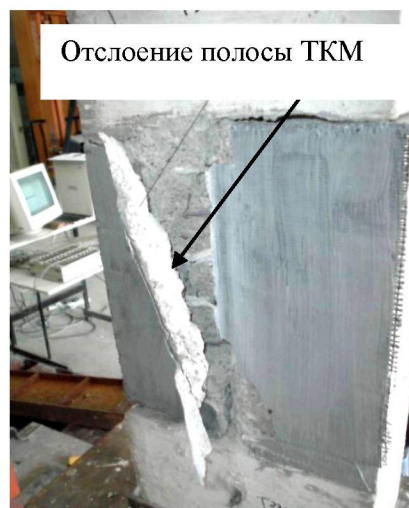
Рис. 13. Отслаивание листа ТКМ от поверхности бетона спецобразца PF3 (задняя сторона)
