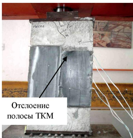
Рис. 12. Отслаивание листа ТКМ от поверхности бетона спецобразца PF3 с внешним армированием из ТКМ (передняя сторона)
