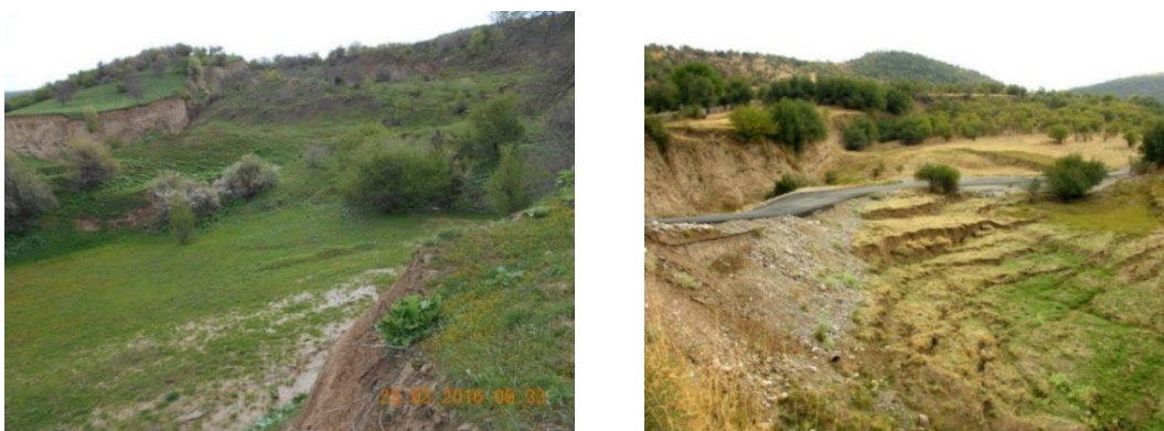
Рис. 3. Зоны и трещины на нижнем откосе.
