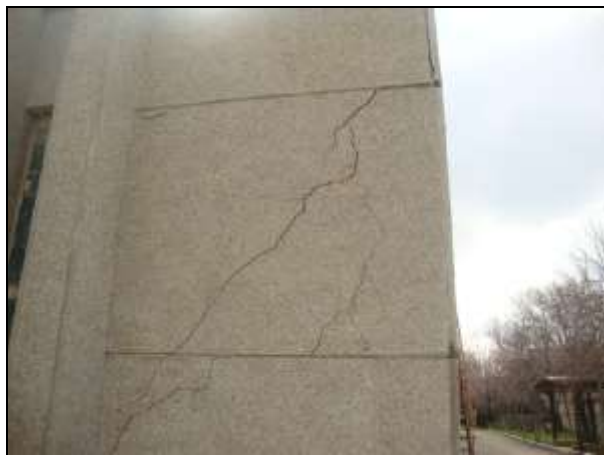
3.4-расм. Том ёлмадаги сувни нотўғри ташкил этиш натижасида девор конструкциясининг муддатидан олдин ишдан чиқиши
