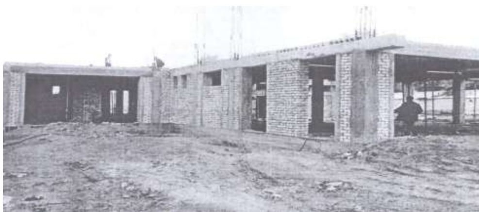
Рис.2.3 Общий вид здания АБК
