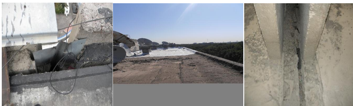
6-расм. Бинонинг том қисмига ёпилган янги фолгоизол материаллар
