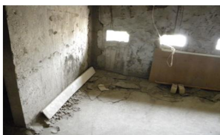
4 -расм. Чордоқни ёз шароитида шамоллатиш учун тешиklar қолдириш.
