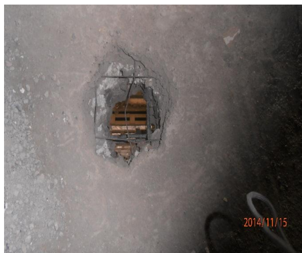
3 - расм. Керамзит бетондан қилинган иссиқлик изоляцияси қопламаси
