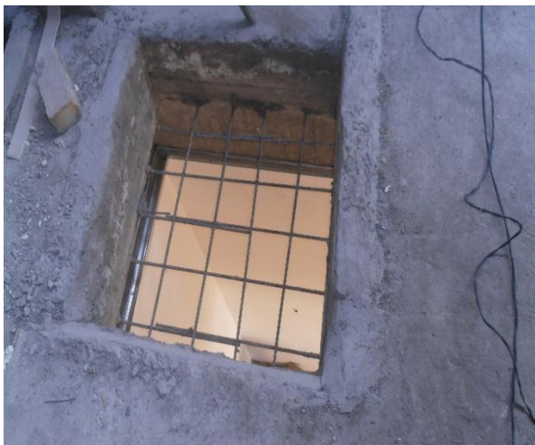
3 - расм. Керамзит бетондан қилинган иссиқлик изоляцияси қопламаси
