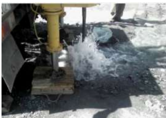
Рис. 4.14. Бурение скважин при постоянном водопритоке
