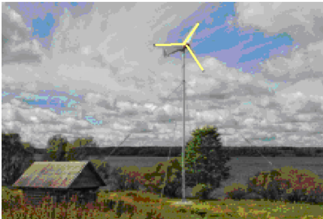
1.14 – rasm. SV-1K rusumli vetroelektrostansiya
