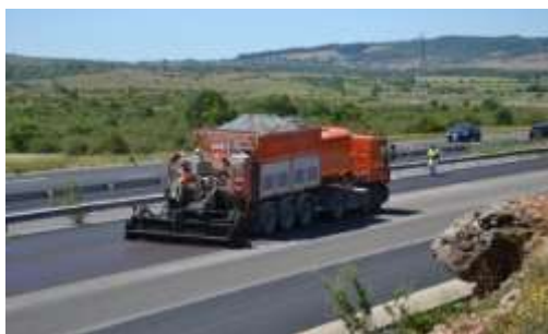
Рис.3.3. Сларри Пейвер с давлением (а) и Сларри Пейвер с насосами (б)
