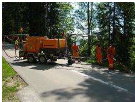
Рис.3.4. Крейссилер АФУ (а) АФУ ТК (б) (Заделка трещин)
