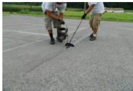
Рис. 2.17. Заделка трещин вручную при помощи лейки
