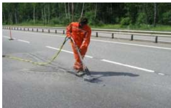
Рис.2.6. Машины для ремонта струйно-инъекционным методом
