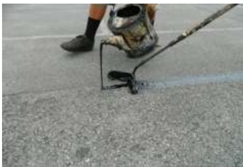
Рис. 2.17. Заделка трещин вручную при помощи лейки
