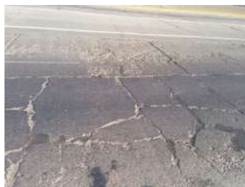
2.13-расм. Цементбетон қопламасини 869 км бўлагидаги устки юзасининг емирилган жойларининг ҳолати.
