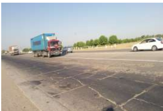
2.13-расм. Цементбетон қопламасини 869 км бўлагидаги устки юзасининг емирилган жойларининг ҳолати.
