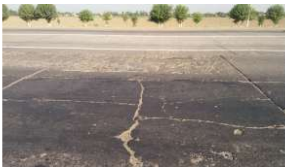
2.12- расм. Қопламадаги пайдо бўлган бўзилишлар 868-869 км.
