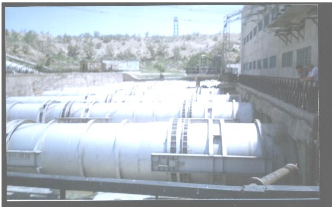
1 – расм. Қизилтепа насос станциясидан чиқувчи сувни сув йиғиш камерасига ташловчи горизонтал сув ўтказгичларнинг жойлашуви
