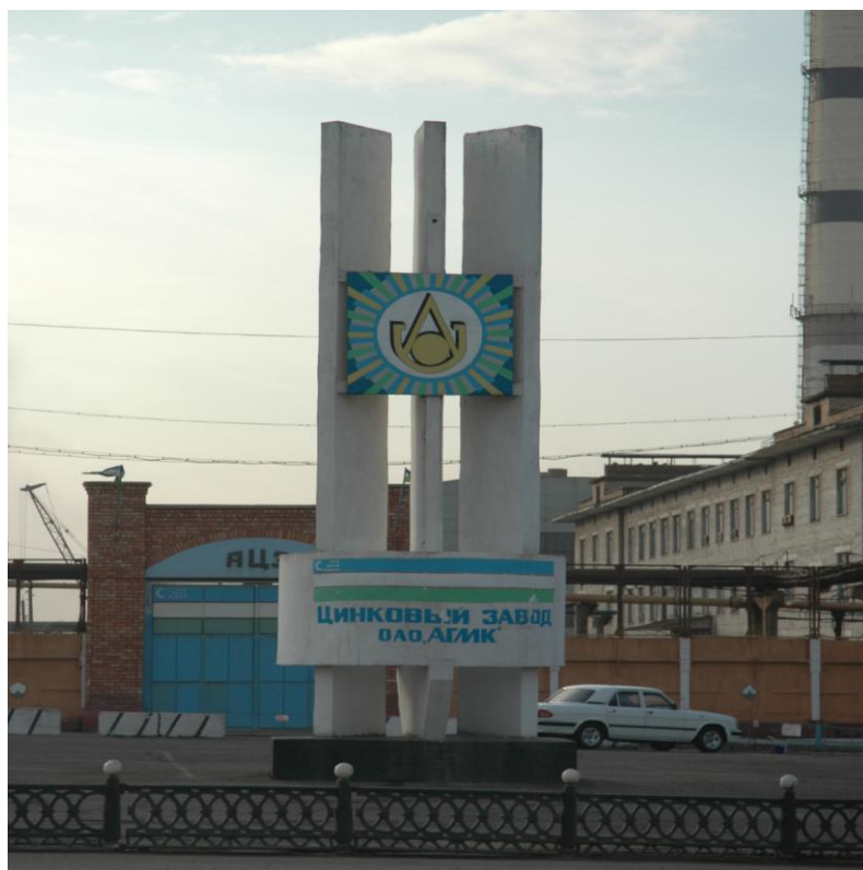
6-rasm. 1970- yilda ishga tushirilgan Olmaliq tog' metallurgiya kombinatiga qarashli rux zavodining umumiy ko'rinishi.
