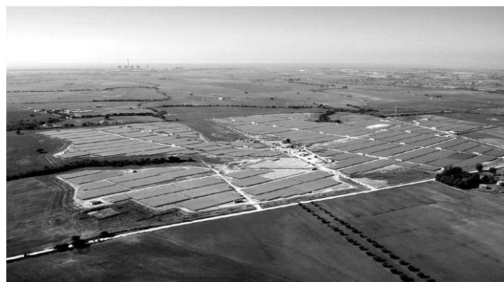
4.17-Rasm. Quvvati 84,2 MVt quyosh fotoelektr stansiyasi: Montalto di Castro PV Power Plant, Viterbo, ItaliY. Kompaniya Sun Power
