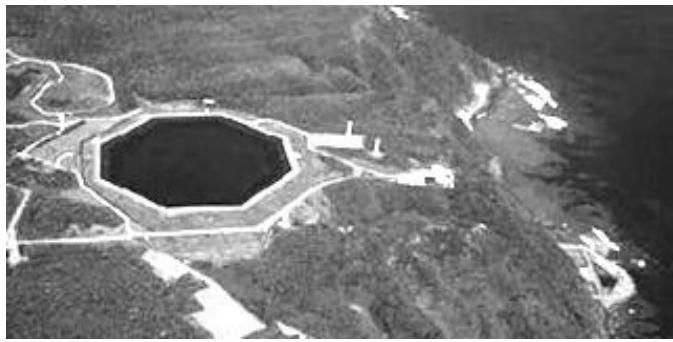
17.8-Rasm To'lqin energiyasi asosidagi gidroakkumulyatsiyalovchi elektr stansiyasi:
