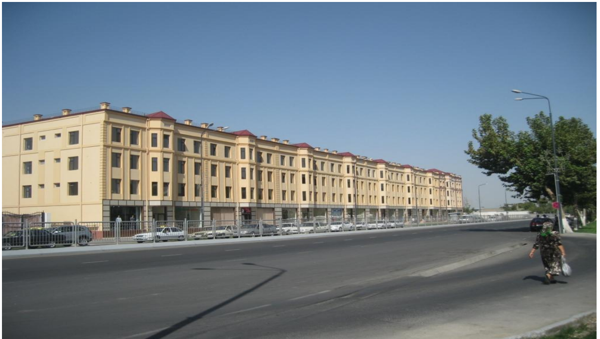
7.3 – расм. Охунбобоев кўчасидаги янги қурилган 4 қаватли турар жой биноси. (Девори пишган ғиштдан, комплекс конструкцияли)
