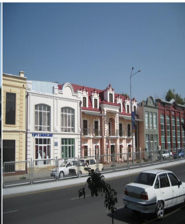
7.5 – расм. М.Улуғбек кўчасидаги янги қурилган ва қайта таъмирланган 2 қаватли турар – жой, магазин ва оффис бинолари. (Девори пишган ғиштдан, комплекс конструкцияли)
