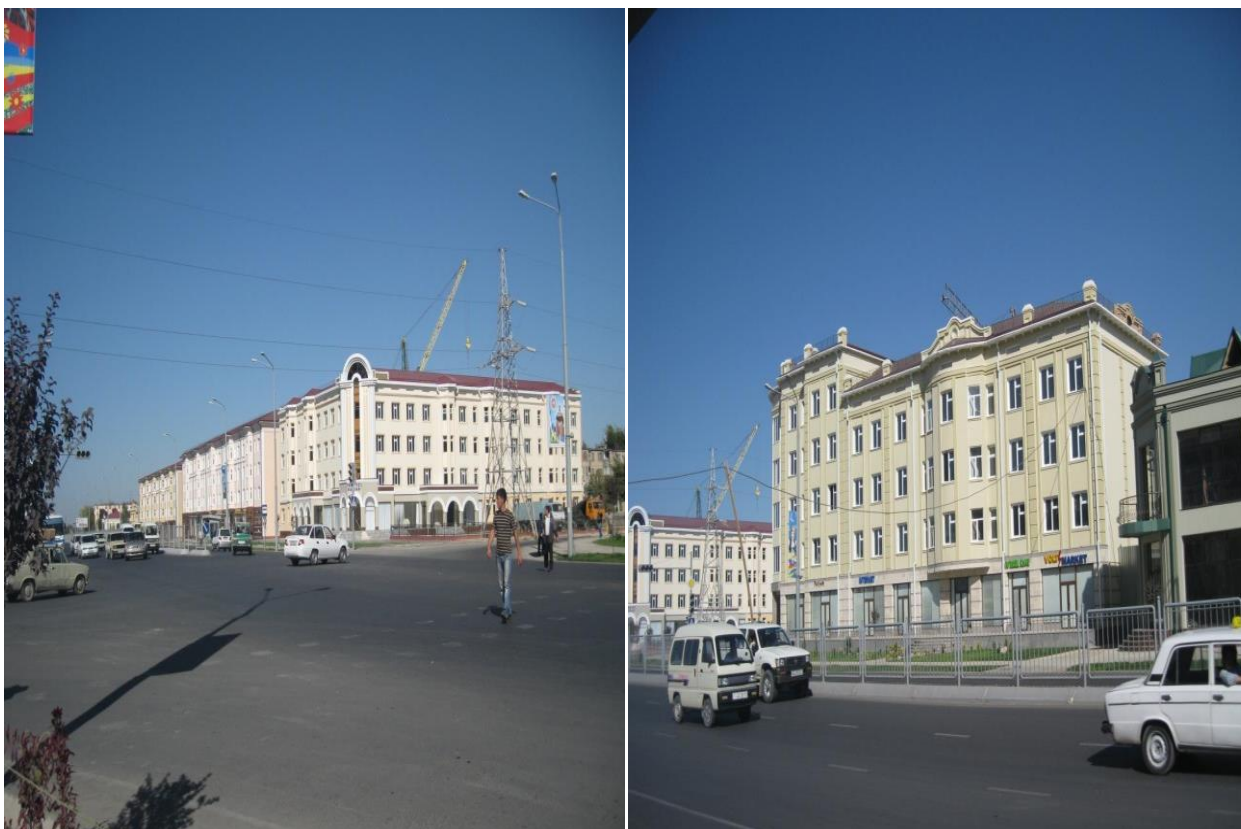
7.7 – расм. Беруний кўчасидаги янги қурилган 4 ва 5 қаватли турар – жой биноси. (Девори пишган ғиштдан, комплекс конструкцияли)
