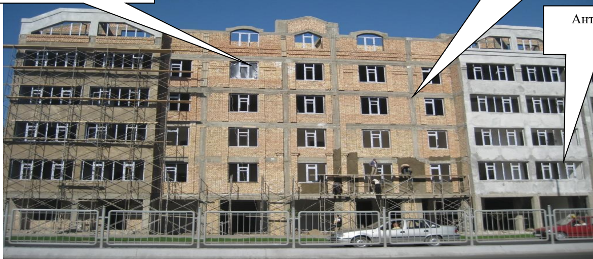
7.9 – расм. М.Улугбека кўчасидаги янги қурилган турар – жой биноси. (Девори пишган ғиштдан, комплекс конструкцияли)
