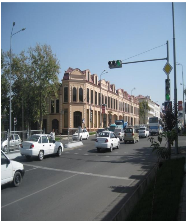
7.5 – расм. М.Улуғбек кўчасидаги янги қурилган ва қайта таъмирланган 2 қаватли турар – жой, магазин ва оффис бинолари. (Девори пишган ғиштдан, комплекс конструкцияли)
