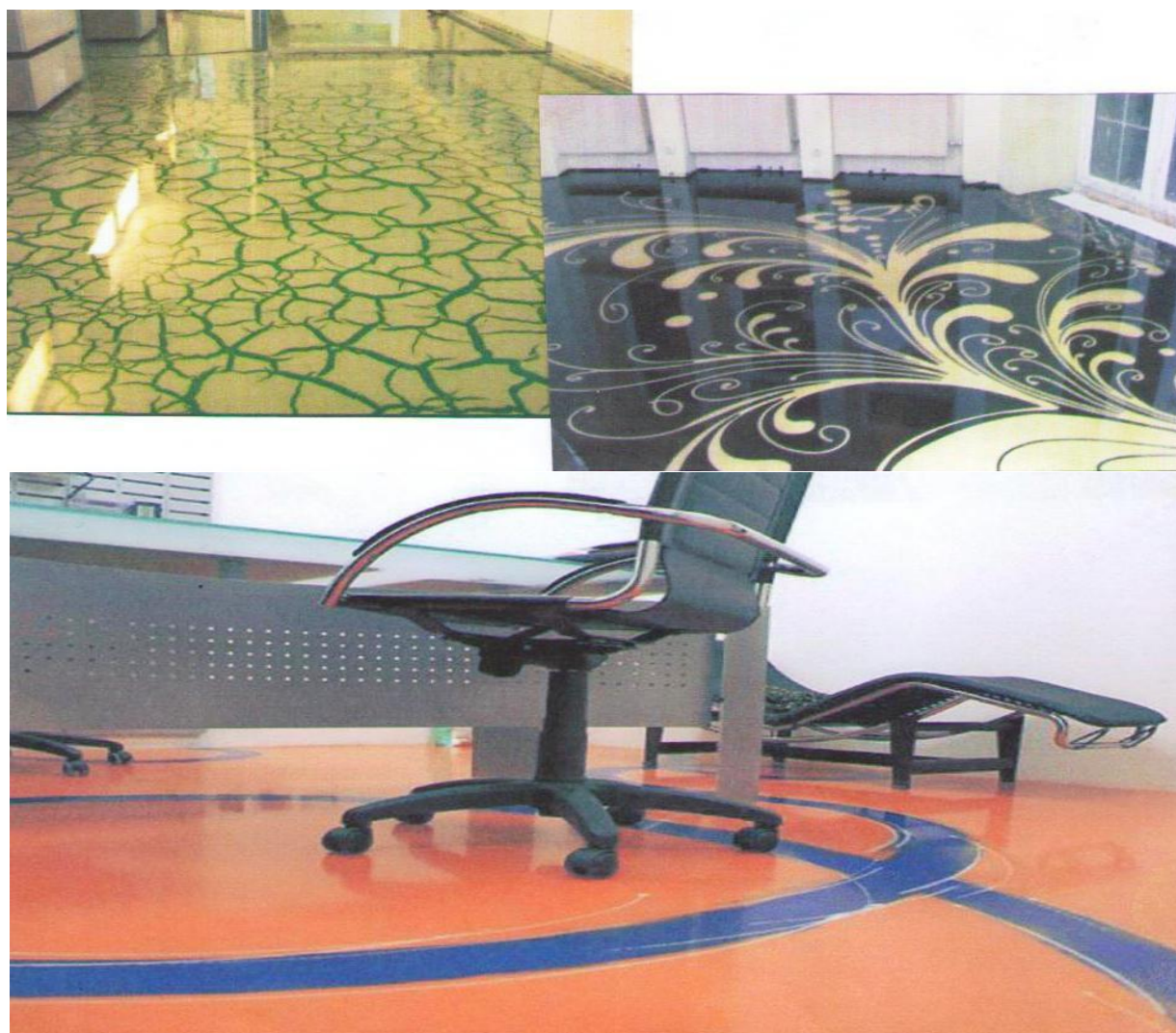
13.15 - расм. Чоксиз яхлит полимер поллар
