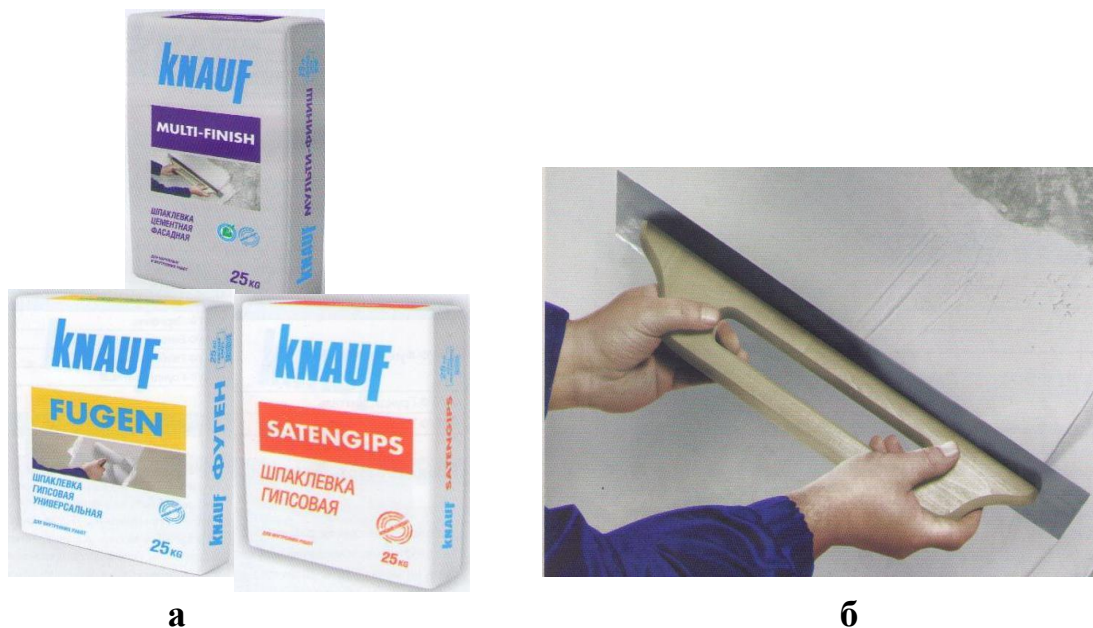
12.3 - расм. KNAUF шпакловкалари ва уларни деворга суртиш
