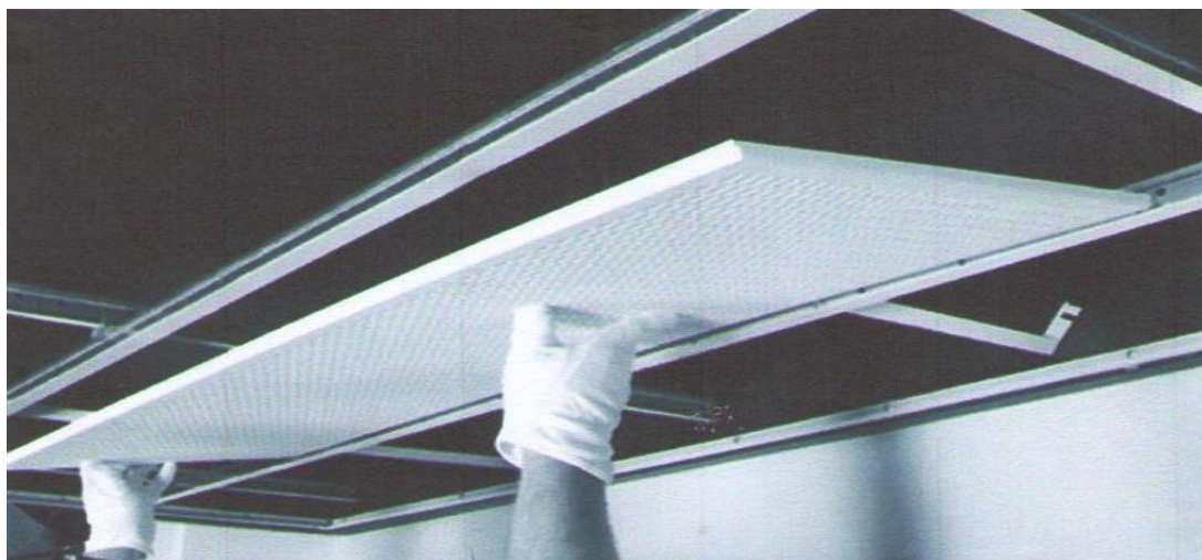
14.8 – расм. Перлитсиликатли иссиқ сақловчи акустик плитани том шифтига ўрнатиш.
