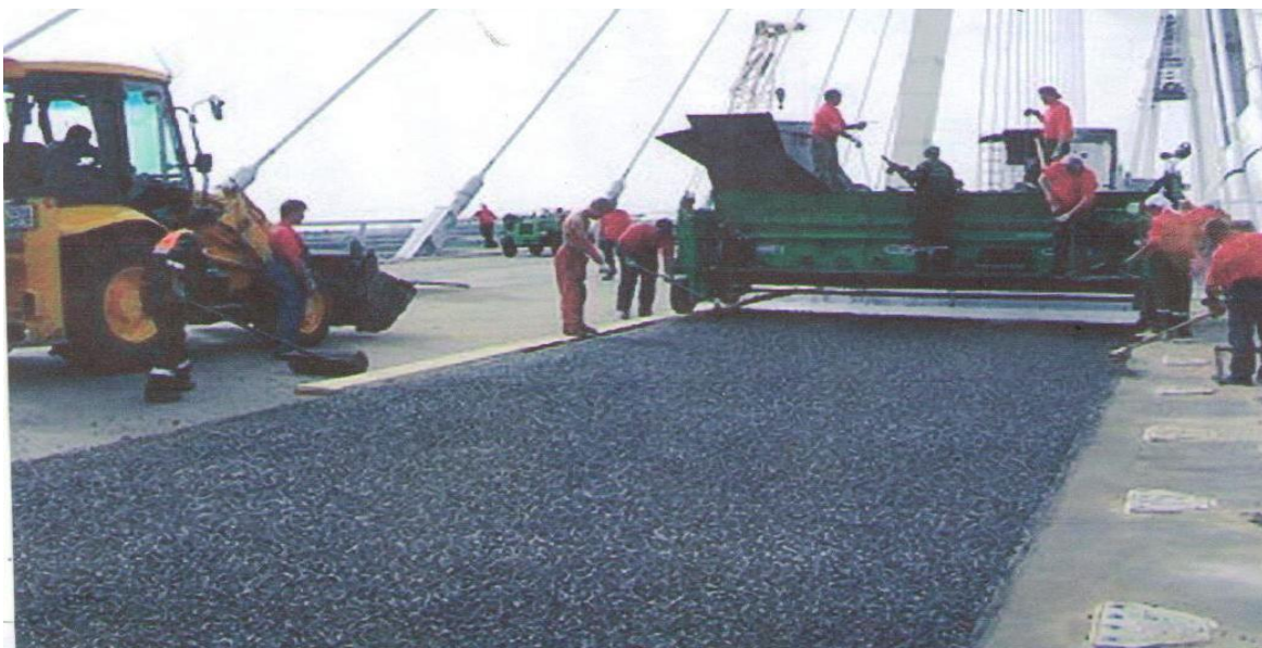
12.2 - расм. Иссиқ асфалтбетон қоришмасини йўл қопламасига ётқизиш ва зичлаш
