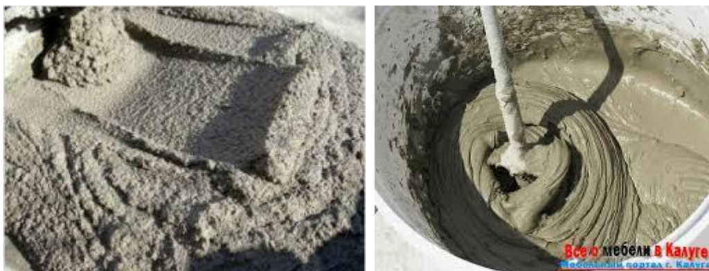
10.8 – расм. Қоришмани тайёрлаш жараёни (а ва ишлатишга тайёр қоришма (б))
