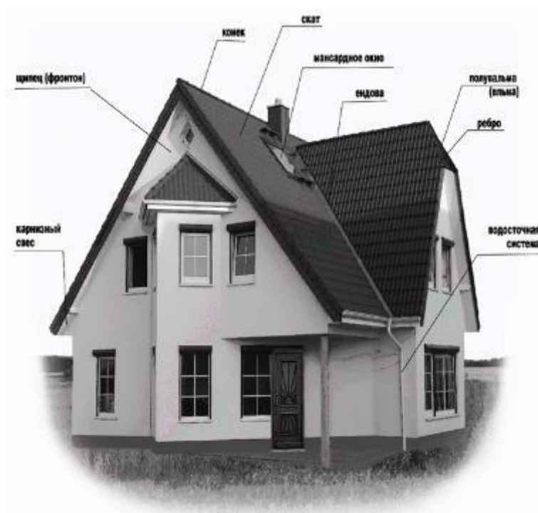
Рис.6.4.Конструктивные элементы современного коттеджа
