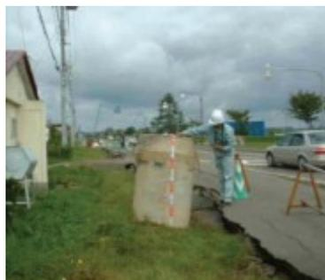
**2-расм. 2003 йил Onbetsu шаҳрида Tokachi-oki зилзиласи таъсирида қудуқнинг бўртиб чиқиши**
