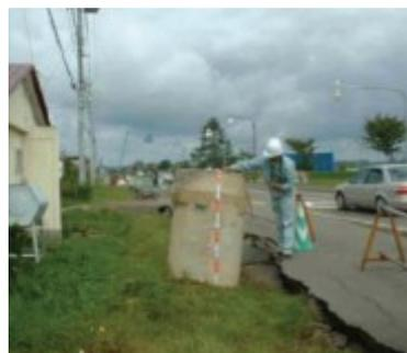
Рис. 2. Поднятый колодец в г. Onbetsu при землетрясении Tokachi-oki 2003 г.
