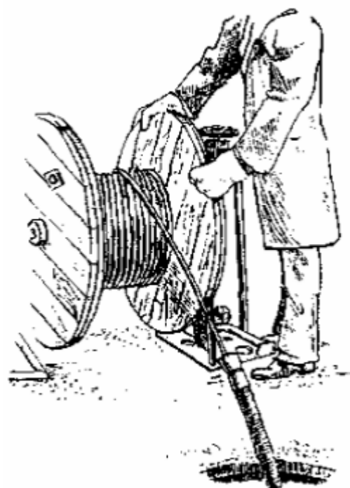
5.4-расм. Кабелни ғалтакдан бўшатиш жараёни
