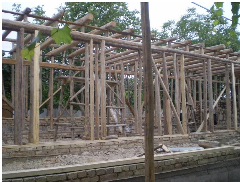
5-расм(а-б). Ёғоч синч девор конструкцияли қурилатган кўп хонали уйнинг олд синч кўринишлари
