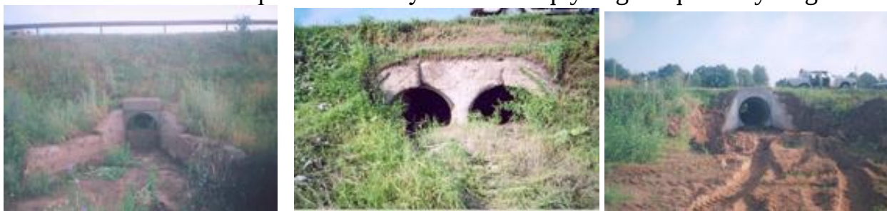
49-rasm. Suv o'tkazuvchi quvurlarni loyqa bosishi, o'simlik qatlamini buzilishi, ko'tarma yon bag'irlari eroziyasi, suvo'tkazuvchi quvurlardagi quvur o'tkazgichlar, suvo'tkazuvchi quvurni mustaxkamligini buzilishi, o'zan yuvilishi va jarlik hosil bo'lishi
