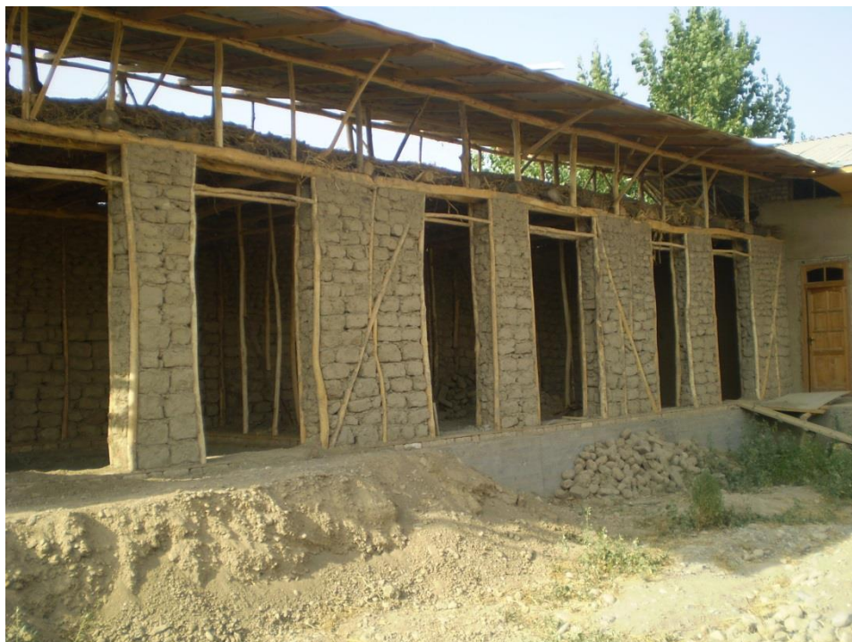
2-расм. Ёғоч синч девор конструкцияли қурилатган кўп хонали уйнинг синч деворини тўлдирилган кўриниши.
