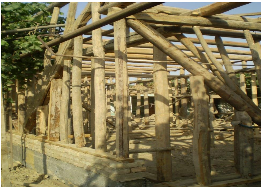
4-расм. Ёғоч синч девор конструкцияли қурилаётган кўп хонали уйнинг бурчак синчлари кўриниши.
