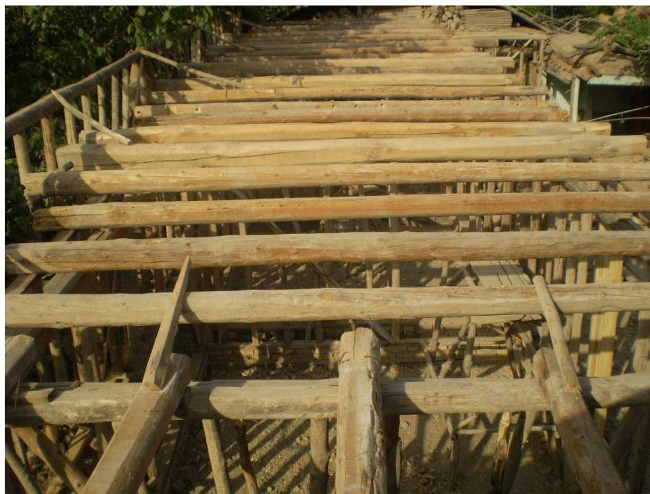
3-расм. Ёғоч синч девор конструкцияли қурилатган кўп хонали уйнинг том тўсини ёпилишининг кўриниши.
