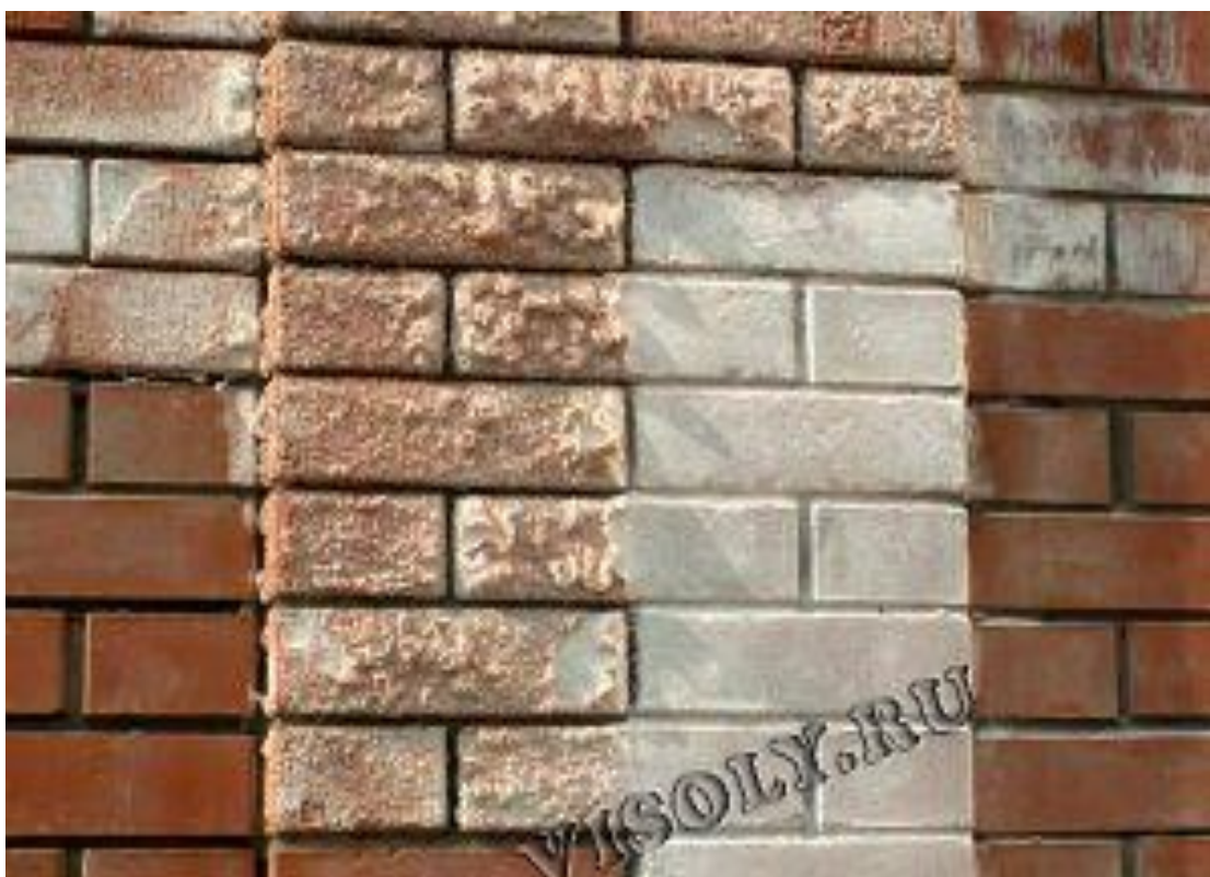
17-rasm. Bino devorlarida tuzlarning kristallanishini borishi va yemirilishi oqibatlari.
