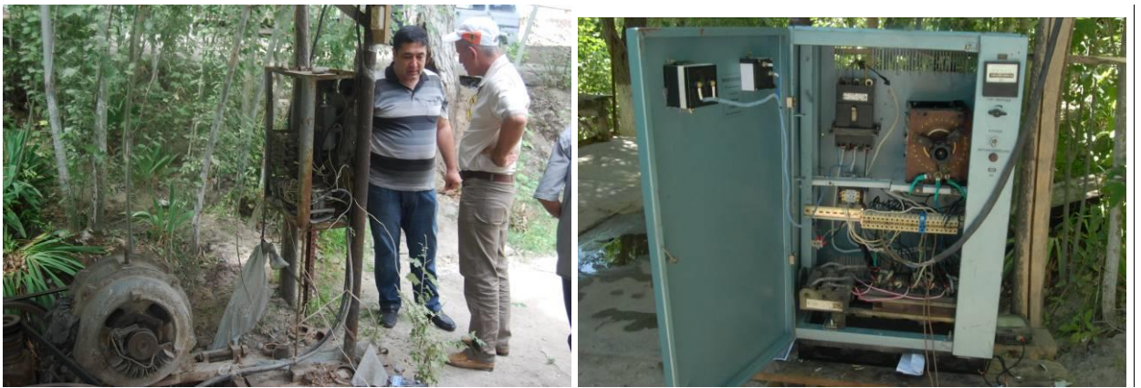
3.9-rasm.TDTU mutaxsirlari elektr boshqarish tizimini butunlay boshqadan yasash zaruriyati muxokama qilishmoqda. O'ngda ular yaratgan yangi boshqaruv shkafi.
