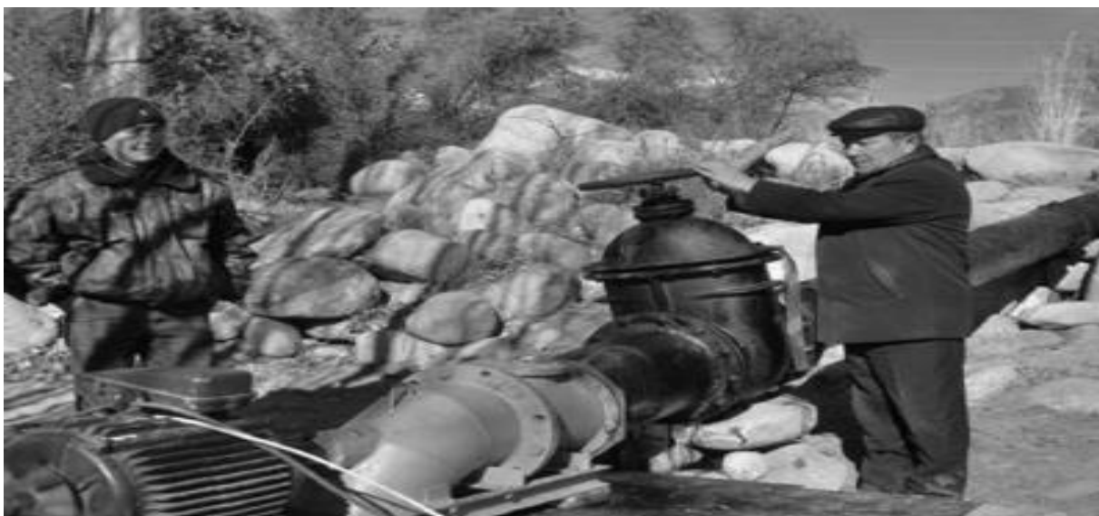
2.12-rasm. 5-kVt quvvatli mikro GES Katta sopol qishlog'i yoki O'rta-Ko'y-Suu daryosi
