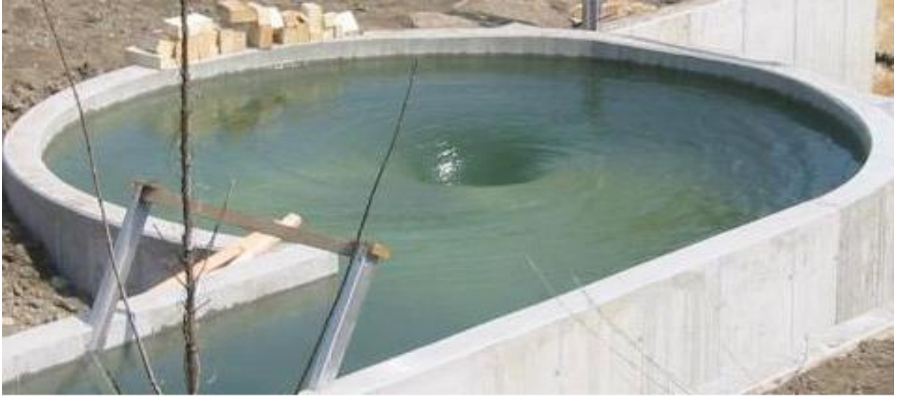
2.13-rasm. Xovuzning suv aylanish diametri 5.5 metrni tashkil etadi. Suv tushishining maksimal balandligi 1.6 metrga yetadi.
