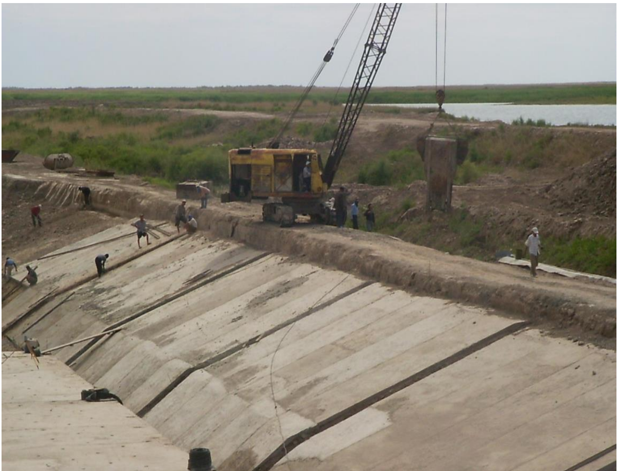
12-rasm. Amudaryo dotalari qirg'oqlarida sun'iy dambalar qurish jarayoni.
