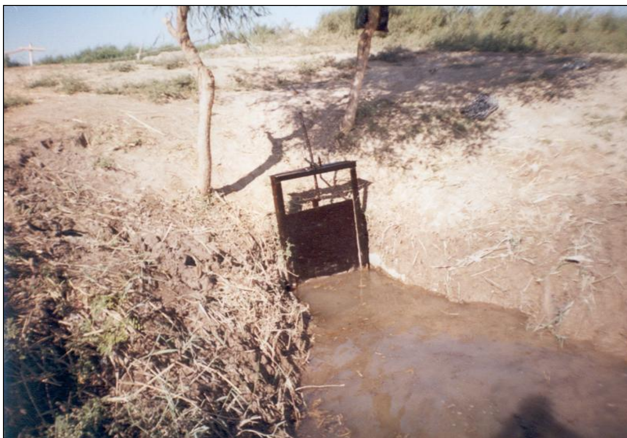
60-расм. Бирламчи зовур охирида сув тўсувчи иншоот.
