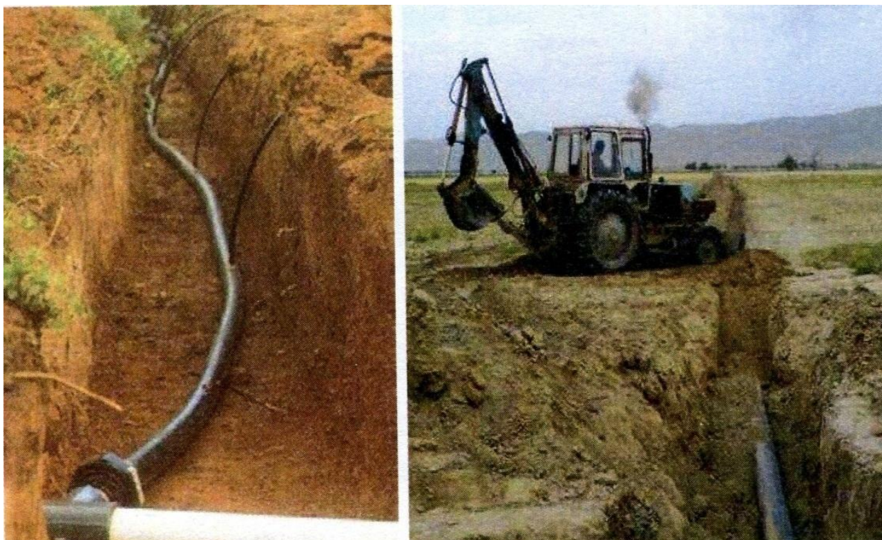
58-расм. Томчилатиб суғориш тизими тарқатувчи қувурини траншея (ариклар) га жойлаштириш ва улаш
