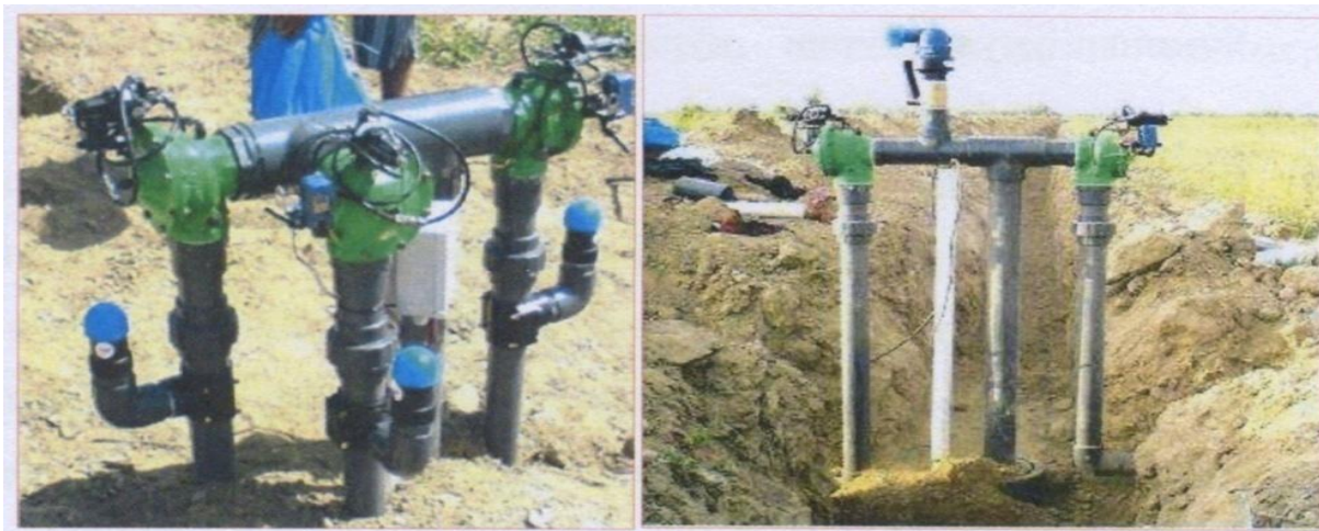
48-расм. Томчилатиб суғориш тизимида ишлатиладиган сув оқимини ростловчи гидрантлар
