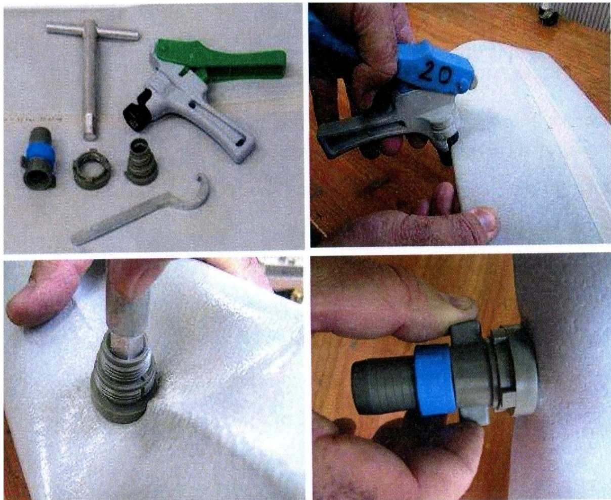
57-расм. Томчилатиб суғориш тизимининг тарқатувчи қувурига штуцерларни ўрнатиш
