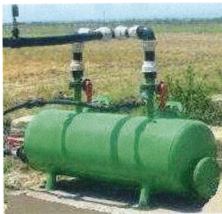
35-расм. Томчилатиб суғориш тизимида ишлатиладиган икки камерали кумли фильтринг умумий кўриниши
