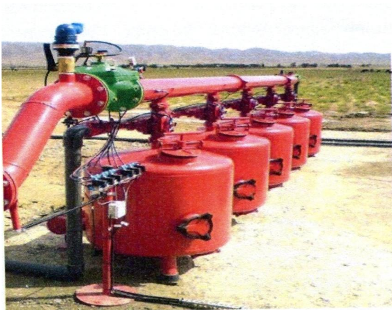
34-расм. Томчилатиб суғориш тизимида ишлатиладиган бир камерали қумли фильтр
