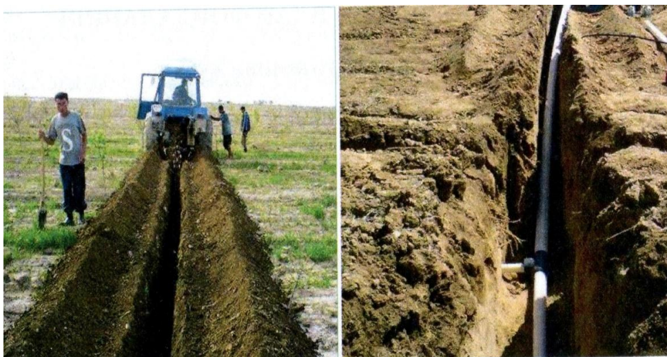
56-расм. Томчилатиб суғориш тизимининг магистрал қувурини қуриш
