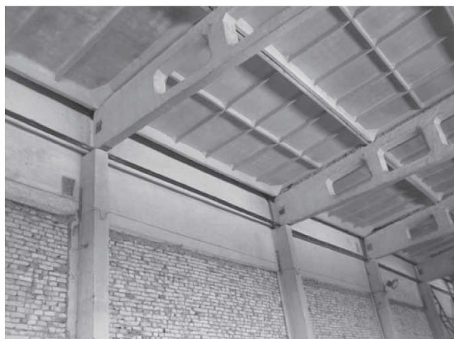
3.11-rasm. Kovakli yig'ma temir-beton yopma to'sinlarning amaliyotda qo'llanilishi.
