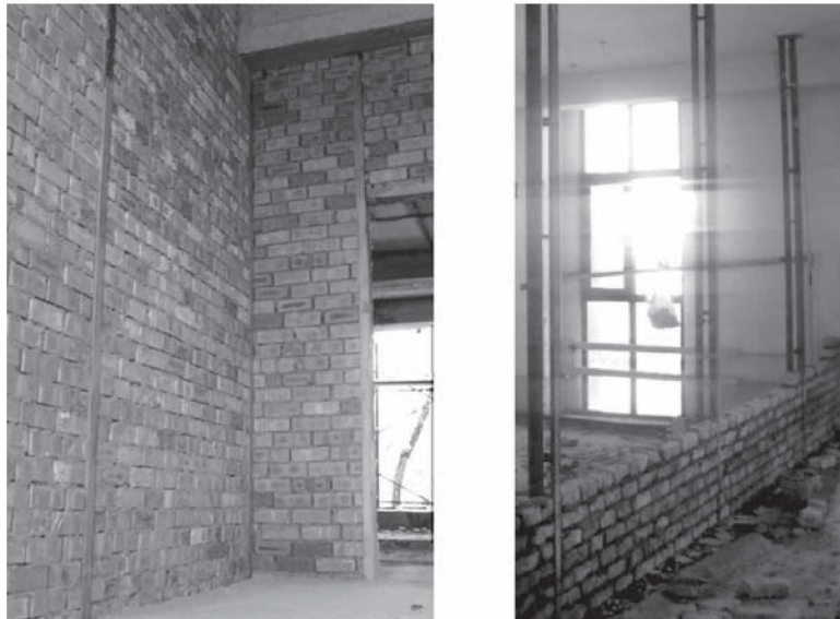
1.86-rasm. Zilzilabardosh qilib ko'tarilgan g'ishtli pardevorlar.
