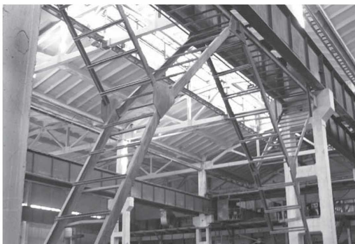
3.30-rasm. Ustunlarda poligonal ko‘rinishdagi bog‘lamalarning amaliyotda qo‘llanilishi.
