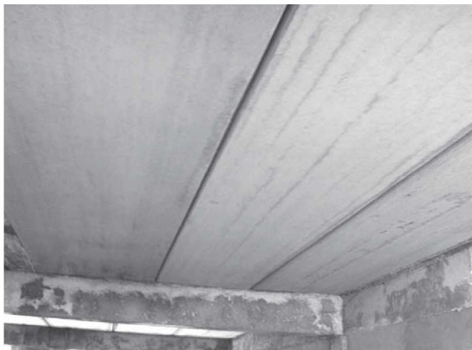
1.99-rasm. Yig‘ma temir-beton to‘sin va orayopma plitalarining amaliyotda qo‘llanilishi.
