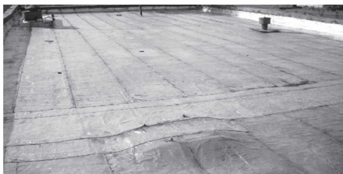
1.47-rasm. Folgaizolning tomda krovli sifatida qo'llanilishi.
