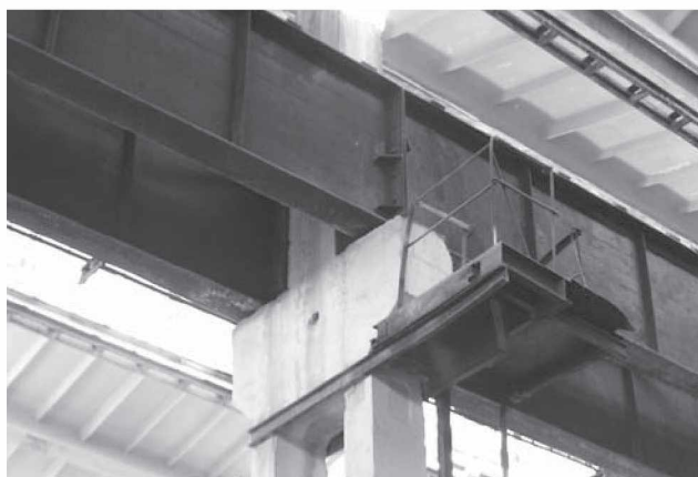
3.9-rasm. Metalldan ishlangan kranosti to'sinlarini ikki shoxli temir-beton ustunga mindirilishi.
