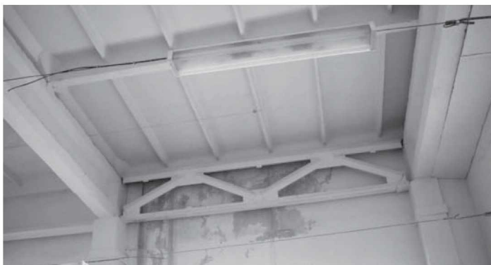
3.31-rasm. Tik bog‘lamalarning amaliyotda qo‘llanilishi.
