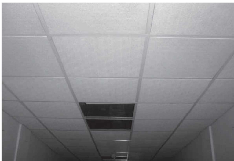
1.100-rasm. Xona shiftining umumiy ko'rinishi.
