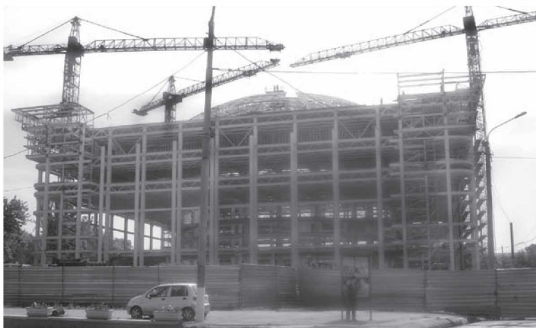
1.4-rasm. Sinchli konstruksiyada metalldan ishlangan Toshkentdagi «O‘zbekiston» xalqaro anjumanlar saroyining qurilish davridagi umumiy ko‘rinishi.
