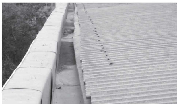
1.77-rasm. Profnastildan ishlangan krovli tarnovi.
