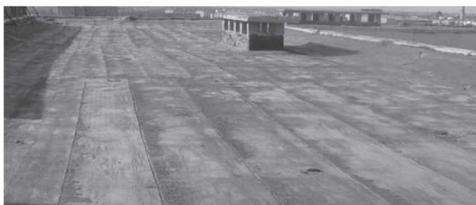
1.46-rasm. Ruberoidning tomda krovli sifatida qo'llanilishi.
