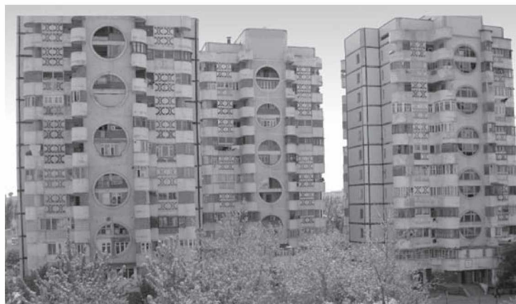
1.6-rasm. Yirik panelli temir-betondan (sinchsiz) qurilgan Toshkent shahrining Ohunboboyev maydonidagi turar joy binolarining umumiy ko‘rinishi.
