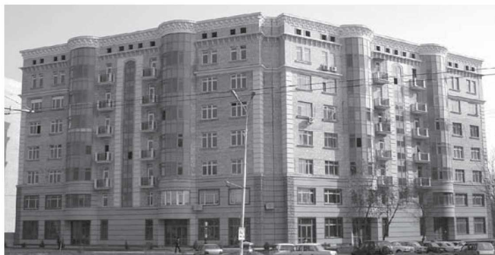
1.24-rasm. Kompleks konstruksiyalar (pishgan g'isht va quyma temir-beton)dan ishlangan zilzilabardosh turar joy binosining umumiy ko'rinishi (Toshkent shahri).
