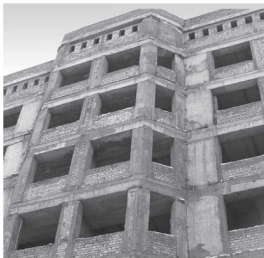
1.39-rasm. Erkerning qo‘llanilishi Toshkent shahrining Navoiy ko‘chasidagi turar joy binolari misolida.
