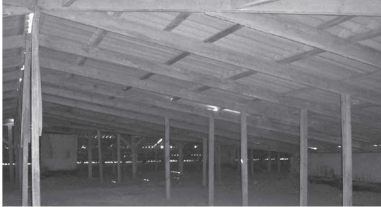
1.54-rasm. Chordoqli tomning umumiy ko'rinishiga misol.
