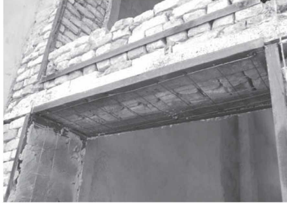
2.11-rasm. Proyoamlarni o'rash (obramlenie) yo'li bilan bino prostenklarini kuchaytirish.
