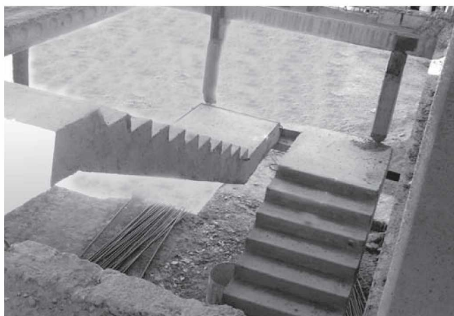
3.78-rasm. Ikki qavatli ishlab chiqarish sexi asosiy zinapoyasining qurilish davridagi umumiy ko'rinishi.
