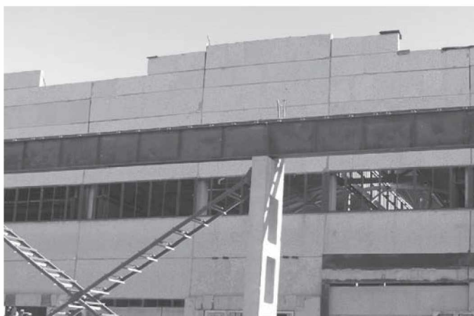
3.53-rasm. Uysozlik kombinati ishlab chiqarish sexi binosi tashqi devor panellarining umumiy ko‘rinishi.
