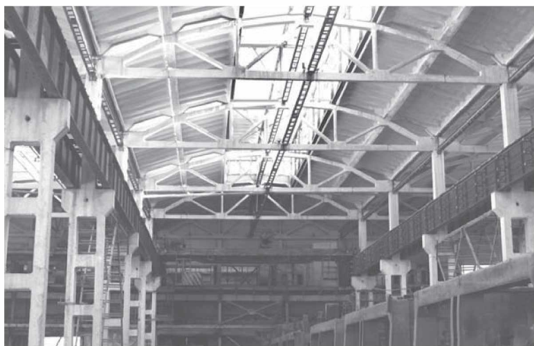
3.4-rasm. Sanoat binosi temir-beton sinchining (ikki shoxli ustun, ferma, qovurg'ali plita, metall bog'lamaning biriktirilishidan tashkil topgan) umumiy ko'rinishi.
