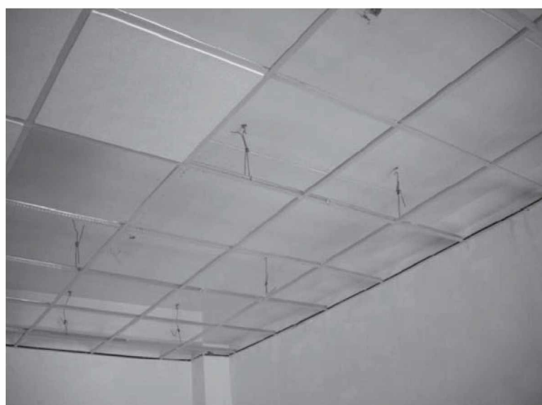
1.101-rasm. Armstrong materialidan ishlanadigan shiftning alumin karkasi.
