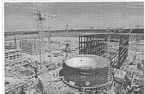
Стройплощадка Нововоронежской АЭС-2
