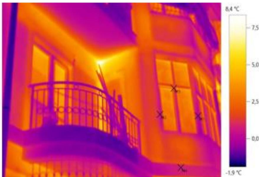
**1-расм. Деворнинг балкон плитаси билан бирикиш конструкциялари туширилган фасад фрагментининг термограммаси.**
