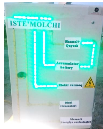
13-расм. ГЭТ бошқарув шкафи комутация жараёни.
