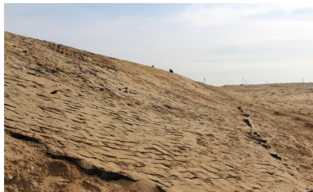
Рис.3. Процесс заполнения ячеек георешеток уложенных на откосы местным грунтом и посев семян пескостойких трав
