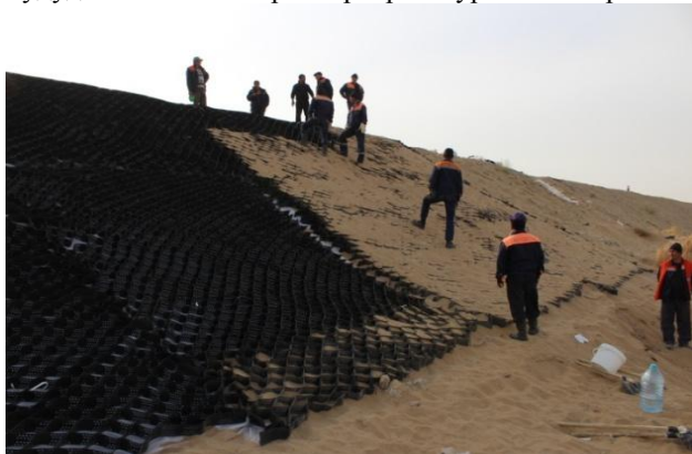
3-расм. Ер полотноси қияликларига ётқизилган геопанжара катакларини маҳаллий грунт билан тўлдириш ва ўсимлик уруғини сепиш жараёни
