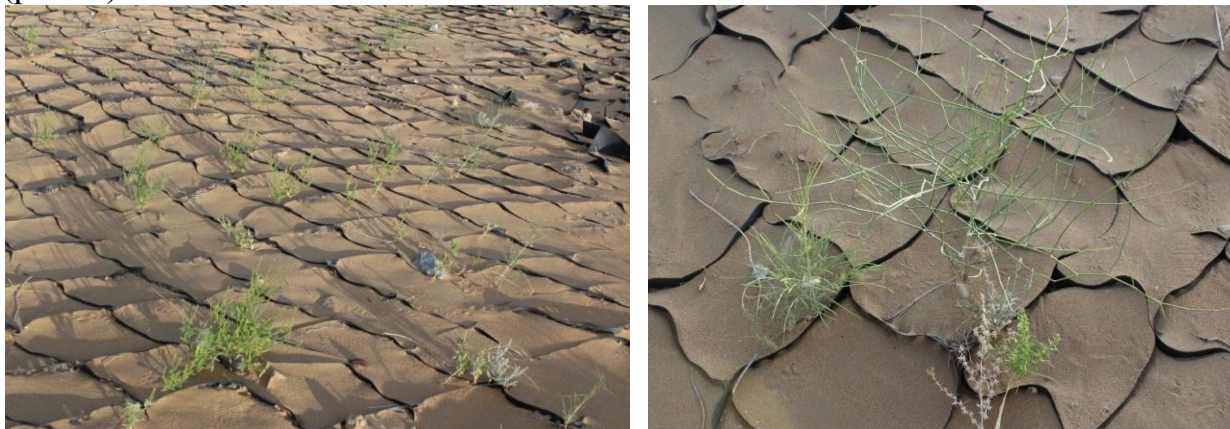
Рис.4. Результаты проведения мониторинга экспериментальных исследований по укреплению откосов земляного полотна с геосинтетическими материалами на перегоне Кийикли – Хизирбобо 4199 км ПК 1
