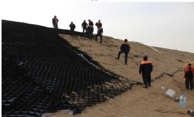
Рис.3. Процесс заполнения ячеек георешеток уложенных на откосы местным грунтом и посев семян пескостойких трав
