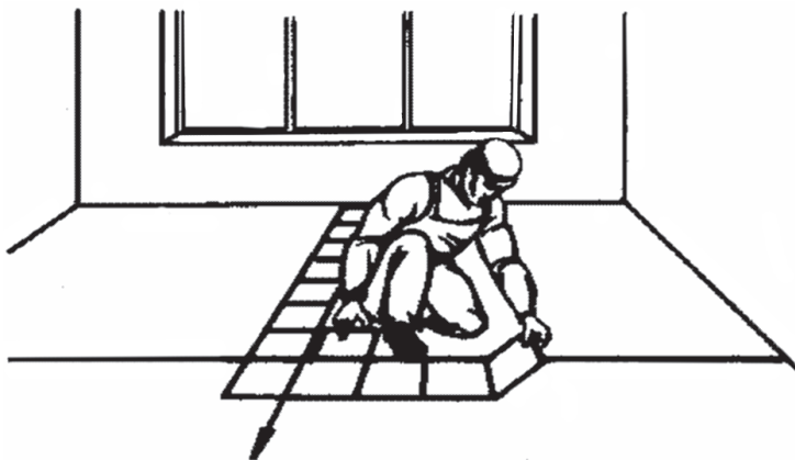
4-rasm. Sintetik plitkani asosga quruq oʻrnatib chiqish sxemasi.
