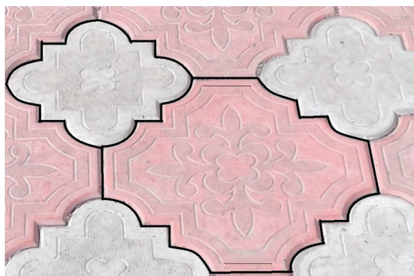
Рис. 1. Один из типов тротуарного покрытия города Черногорска
