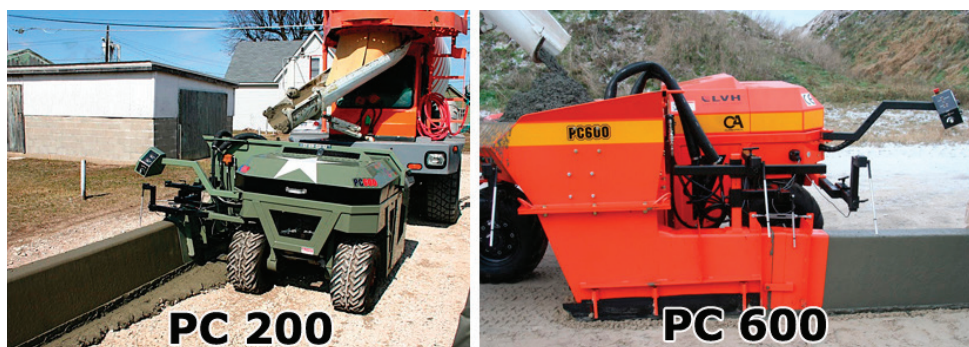
Рис. 2. Бетоноукладчик со скользящими формами фирмы Wirtgen
