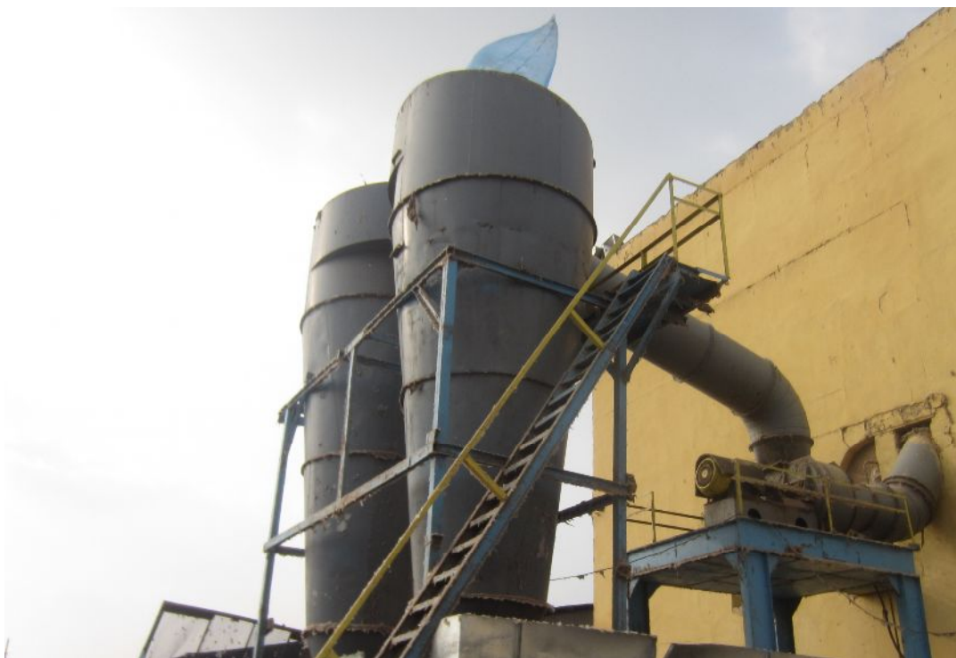
2.12-расм. “Митан пахта тозалаш” АЖ корхонасида атмосферага чиқиб кетаётган толали чиқиндиларни ушлаб қолиш ҳолати.
